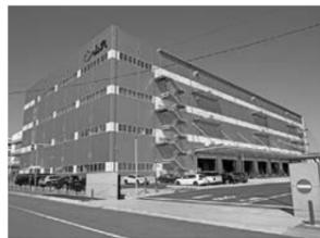
同センターは、現在再編作業が進む横浜港で中心的な役割を担う本牧ふ頭に位置し、東京都心、羽田空港に車で30分圏内という優れたアクセスを有するほか、本牧ふ頭の在来船用岸壁に隣接しているため、在来貨物については、本船接岸からの入出庫作業や、はしけ作業にも対応できる。敷地面積1万5,027.75㎡にS造り4階建て、面積2万921㎡（うち倉庫1万7,025㎡）で、垂直搬送機4基、荷物用エレベーター1基を装備。1階の岸壁側が高床式でコンテナ・トレーラー用でドックレベラー10基を備え、陸側が低床式で通常のトラック用のバースで、13mのひさしを備え、雨天時の作業も可能だ。
