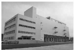
同センターは高効率自然冷媒（NH<sub>3</sub>/CO<sub>2</sub>）冷凍機とLED照明の採用による環境負荷低減と、入退室者の体表面温度測定を兼ねた顔認証システムでのセキュリティ機能を備えるほか、自動化設備などの先端技術を導入した最新の冷蔵倉庫だ。また、自動運転フォークリフトをはじめとした最新の自動化設備を導入し、業務効率化を進める。輸配送機能は、周辺既存拠点との輸配送網の構築やグループ会社であるNKトランスの事業所を設置することで運送機能の強化、トラック予約システム導入による車両待機時間の短縮を実現する。設備はF級冷蔵庫8812トン、FC級兼用が7,756トン、C級1万4,205トンを備え、地上4階建て免震構造（冷蔵倉庫部分）、接車バースは24基。また同倉庫はその後、NPO法人日本ハラル協会からハラル認証を取得している。
